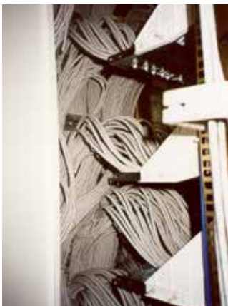
Mauvaise gestion des câbles
